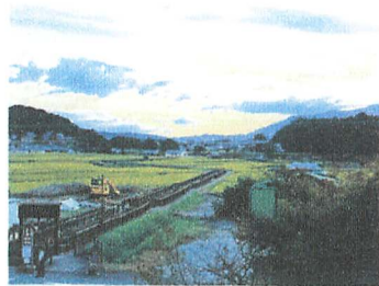
資料27 (写真13) 手前は水平に設置された吉野川分水で右手奥の低い山陰は甘橙丘 Oct. 5, 2018撮影
